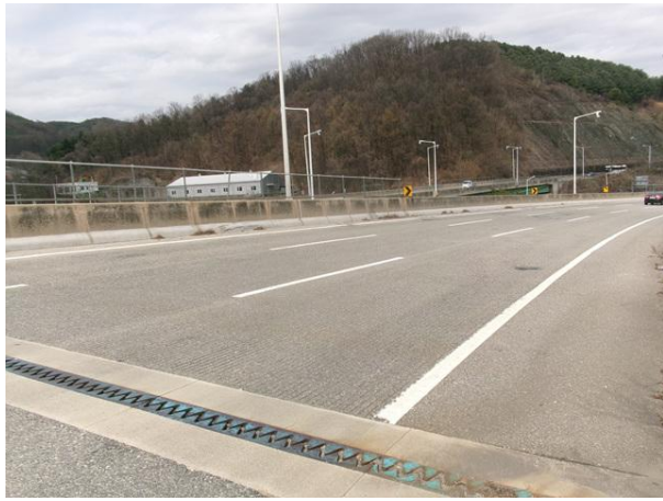
교량 상부 전경
